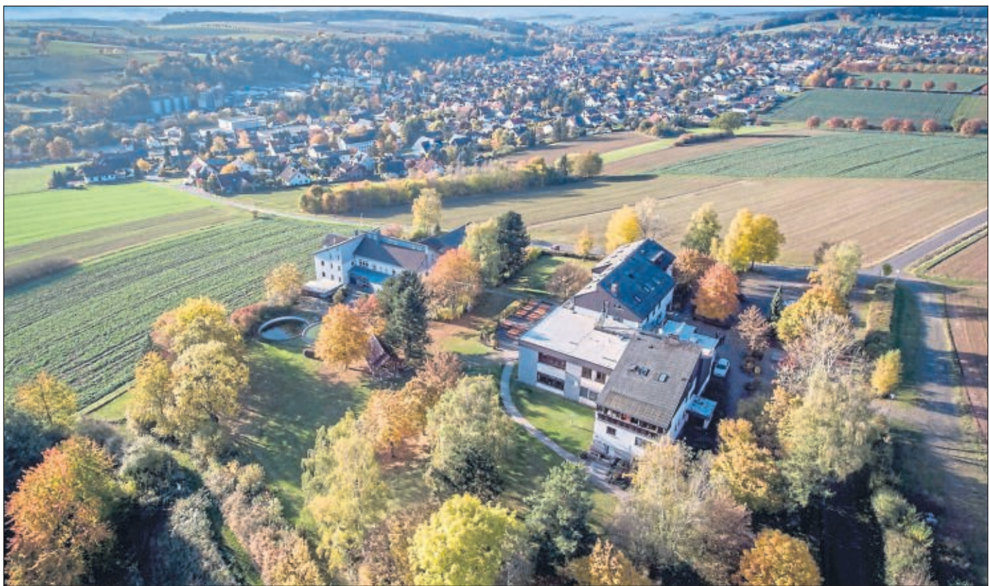
Lage oberhalb der Stadt Neukirchen: Nachdem die Geschäftsstelle des Landesverbandes in Kleinenglis in den 1960er-Jahren zu eng wurde, entschied sich der Landesverband für den Neubau eines Freizeitheims im Knüll.
